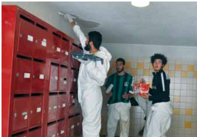
Exemple d'un chantier d'insertion qui pourrait être pris en charge par la Régie de quartier, ici au Gué-aux-Biches en juin 2017
